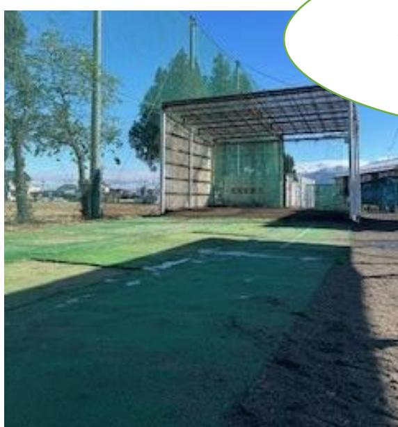
人工芝を設置し、マウンドの傾斜を修正しました。また、土が流れていかないよう U字溝を設置しました。すべて手作業で行いました。
